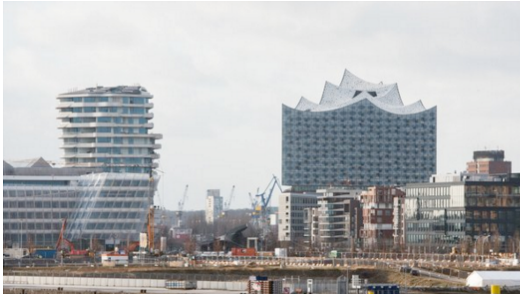
Baufläche für das südliche Überseequartier der Hafencity © Daniel Bockwoldt/dpa
