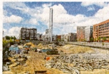
Die Baugrube für das Milliardenprojekt im südlichen Überseequartier
